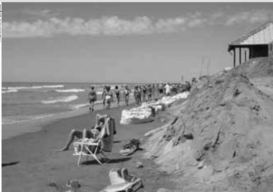
A las modificaciones propias de la dinámica costera se le suman otras que son ajenas a su naturaleza: el aumento del nivel del mar debido al cambio climático, y los efectos de la urbanización causados por una deficiente planificación y falta de políticas adecuadas.
