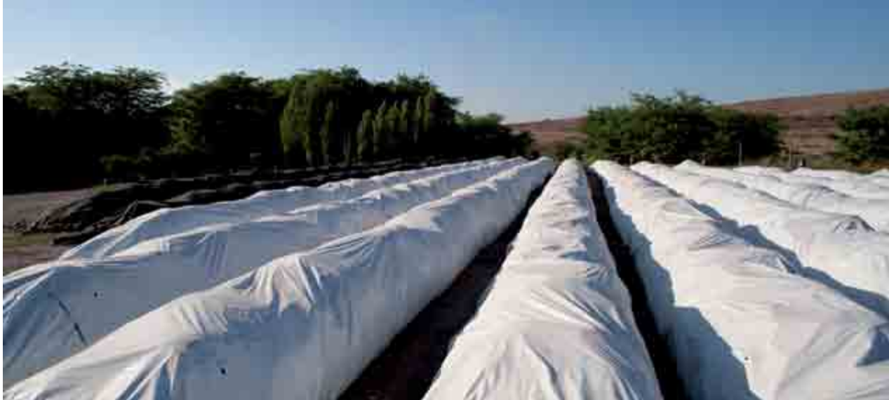
En el año 2001 CEAMSE construyó una planta de compostaje en el Complejo Ambiental Norte III con una capacidad de tratamiento de 1.200 a 2.000 t/mes de residuos verdes, siendo el emprendimiento de su tipo más importante del país. Fuente: CEAMSE
