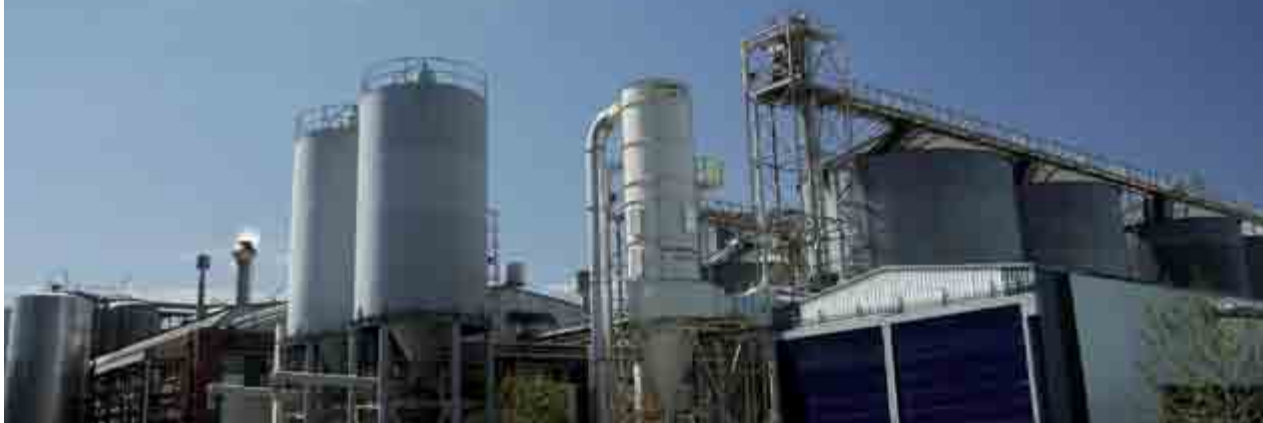
El caso de la cervecería Quilmes, en la planta de Zárate, es un ejemplo del aprovechamiento de los subproductos para la generación de biogás, que representa cerca del 2,5% de las necesidades energéticas de la planta. Foto: www.cerveceriaymalteriaquilmes.com
