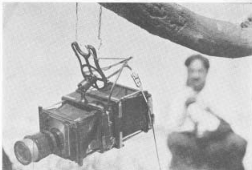
Fig. 1. — Cámara de mano con dispositivo para colocarla suspendida, el que al mismo tiempo permite la orientación requerida para una toma con teleobjetivo "Magna".
