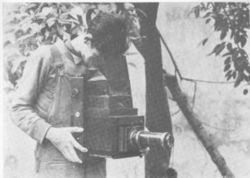
Fig. 1. — Cámara "Mentor" para 18 x 18 cm con enfoque de espejo y equipada con teleobjetivo "Stainbellein" dispuesto para un foco de 12 cm.
