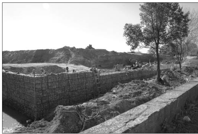
Las obras en estado avanzado frente al Pabellón II
