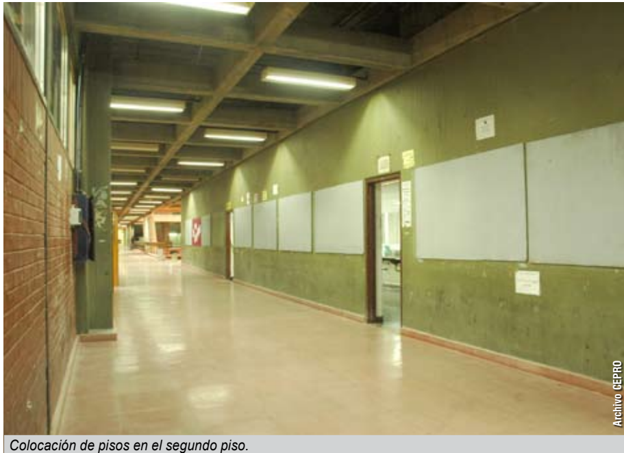
Colocación de pisos en el segundo piso.
