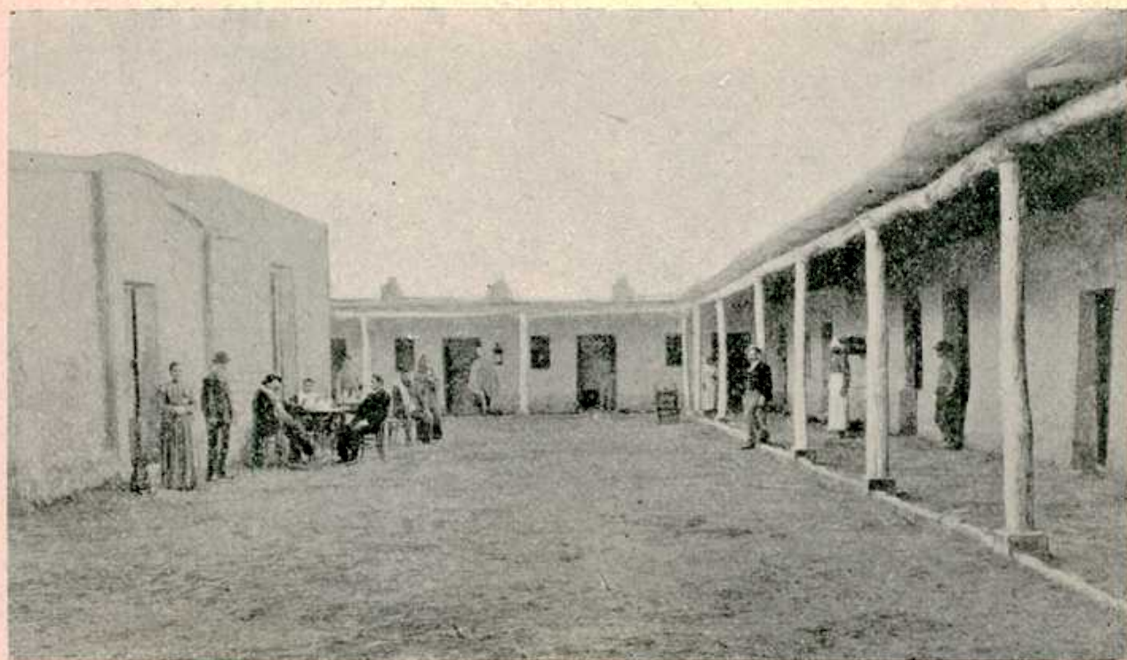
SAN JUAN.—BAÑOS DE «LA LAJA».—PATIO INTERIOR.
