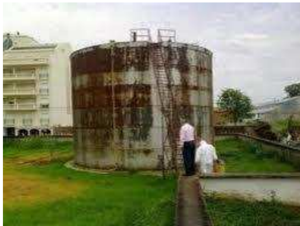
Figura 1.3. Tanque de fuel-oil de la ex-usina de Corrientes, donde se observa la cercanía de las construcciones urbanas (Julio/2011)
