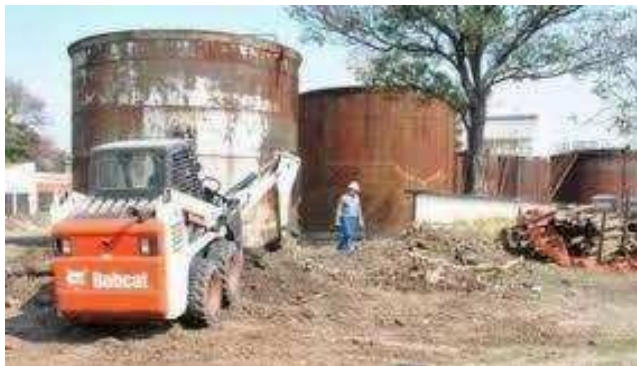
Figura 1.4. Imagen tomada de los medios de difusión masiva del momento en que se realizaban los trabajos de desmantelamiento de los tanques de la ex-usina.
